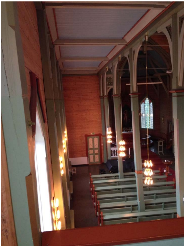
Figur 2: Søylar og langvegger er ute av lodd (illustreres av lysekronene som henger i lodd).
