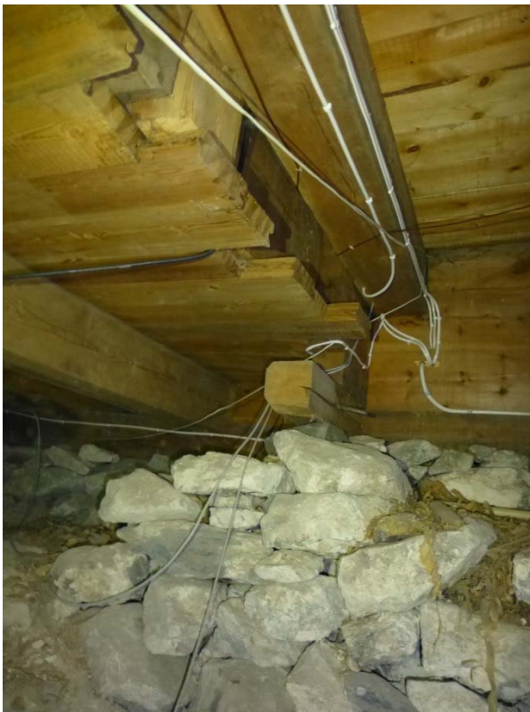
Figur 5: Kryp Kjeller i område som skal få ny fundamentering. Omlegging av tekniske føringer inngår i arbeidene.
