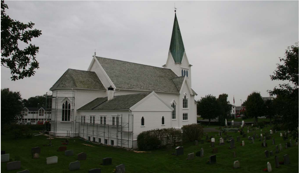
Figur 1: Manger kirke ifm restaureringsarbeider i 2006 (Foto Even Skulstad)
