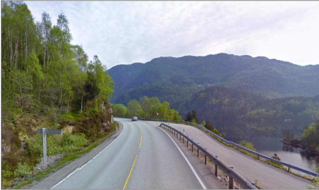
Figur 23: E 39 - Molvikkrysset, mange kryss langs E 39 er ukanaliserte og har dårleg sikt, slik som dette.
