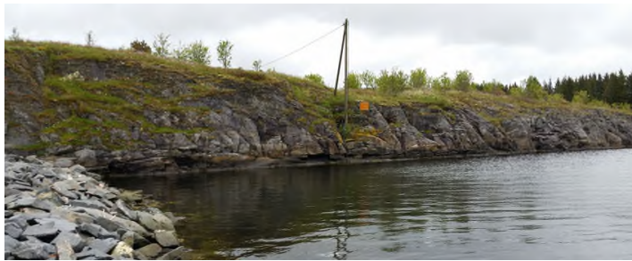
Figur 8 Sørøstleg del med sprengsteinsfylling og bratt strandlinje
