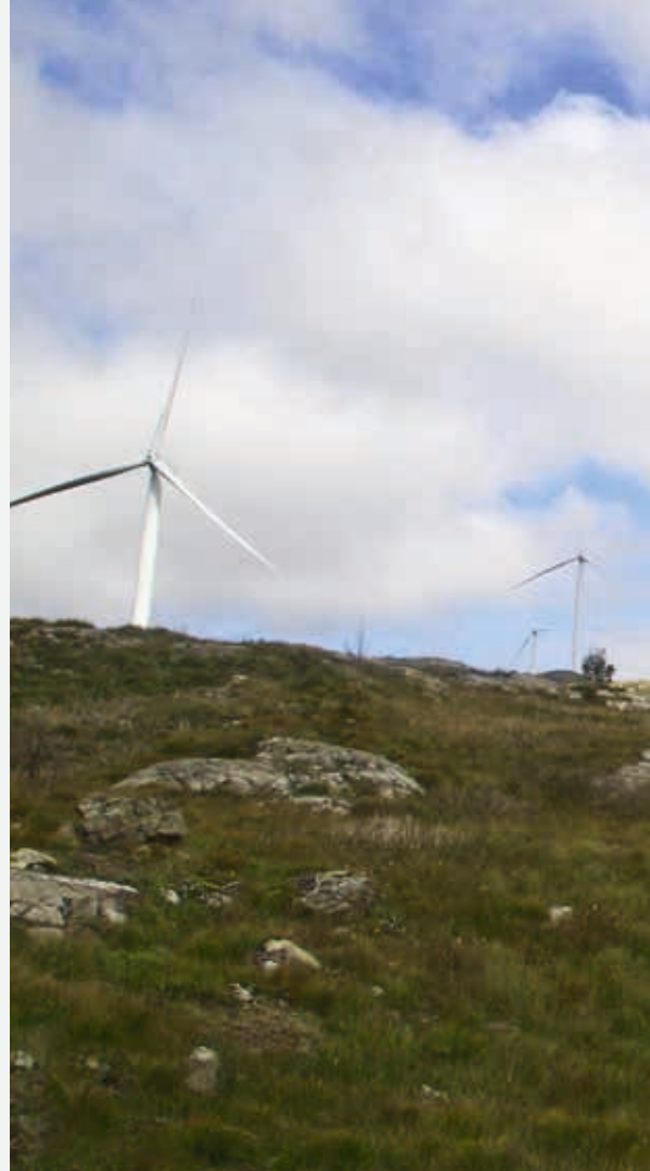
Midtfjellet vindpark i Fitjar kommune. Risikopotensial: Regionens store avstander er krevende både ved ulykker og gress- og krattbranner i til dels ulendt terreng.
