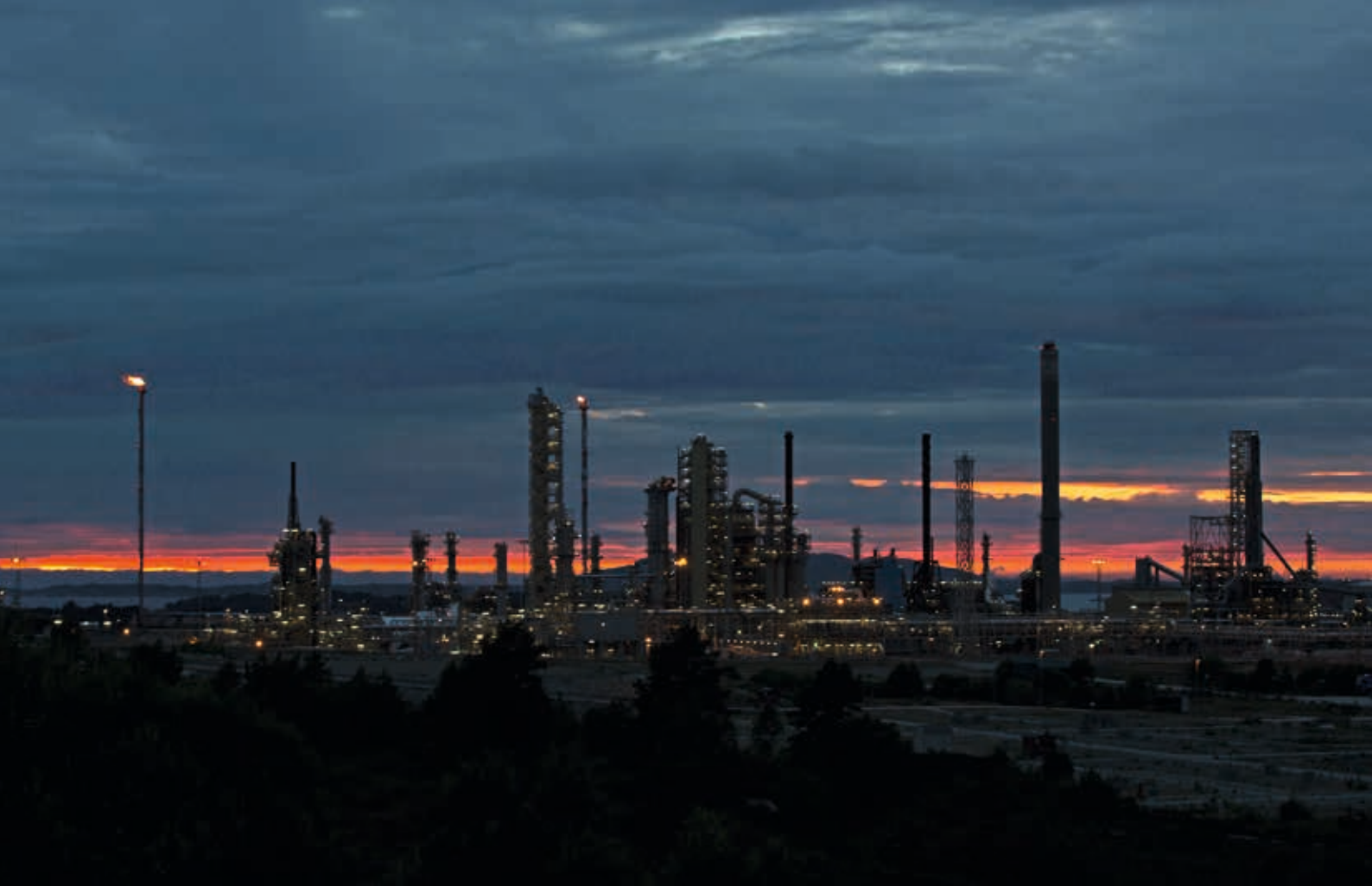
Oljeraffineriet på Mongstad i Lindås kommune. Risikopotensial: Brann og annen storulykke knyttet til olje- og gassinstallasjoner, samt transport.
