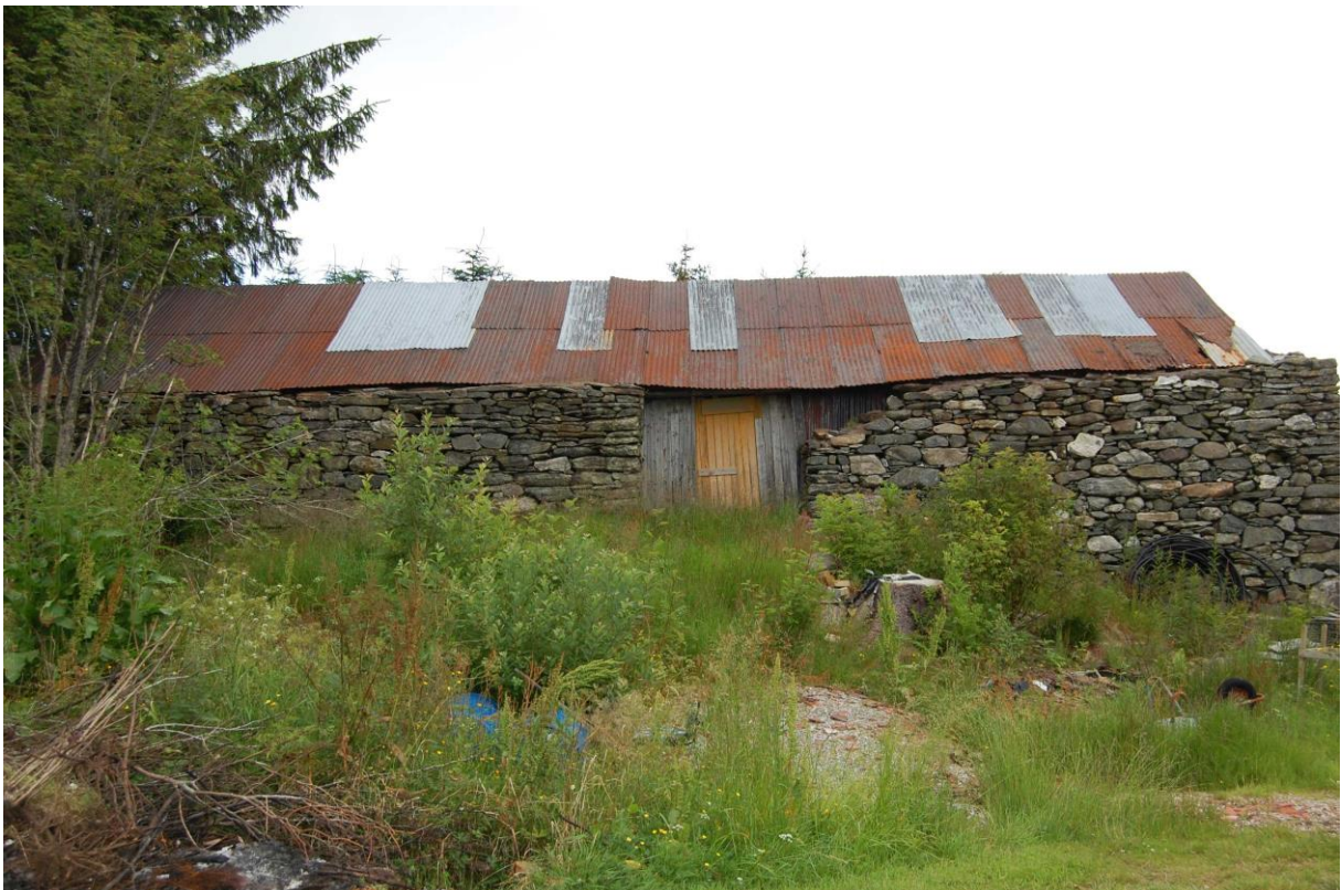
Bilete av løa tatt frå vest. På ei av grunnsteineina til høgre for døra er årstalet 1808 hogd inn.
